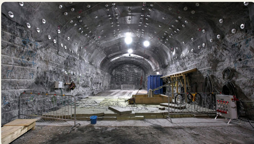
Ondergrondse eindberging in aanbouw (Finland)
